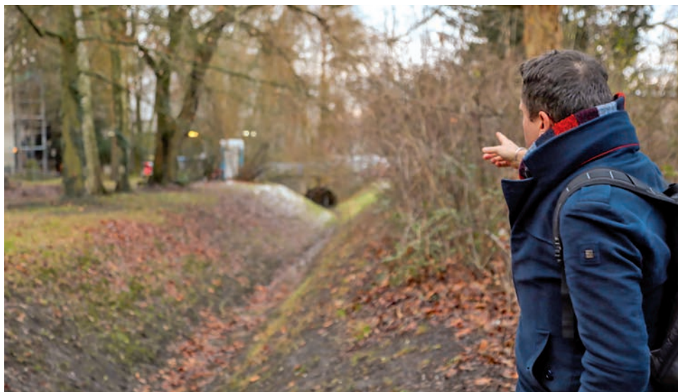
Hinten verschwindet der Lichtenrader Graben unter der Bahnhofstraße
