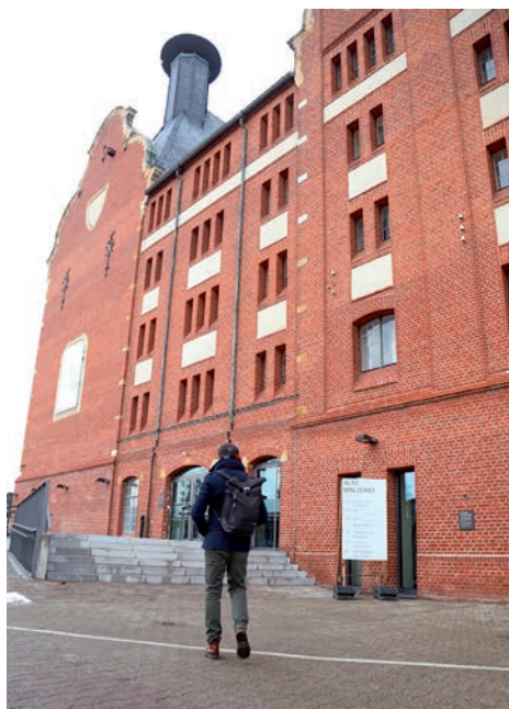
An der „Nahwärme-Insel“ Alte Mälzerei
