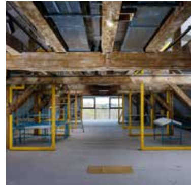
5. Obergeschoss/Dach Kindermuseum unterm Dach
