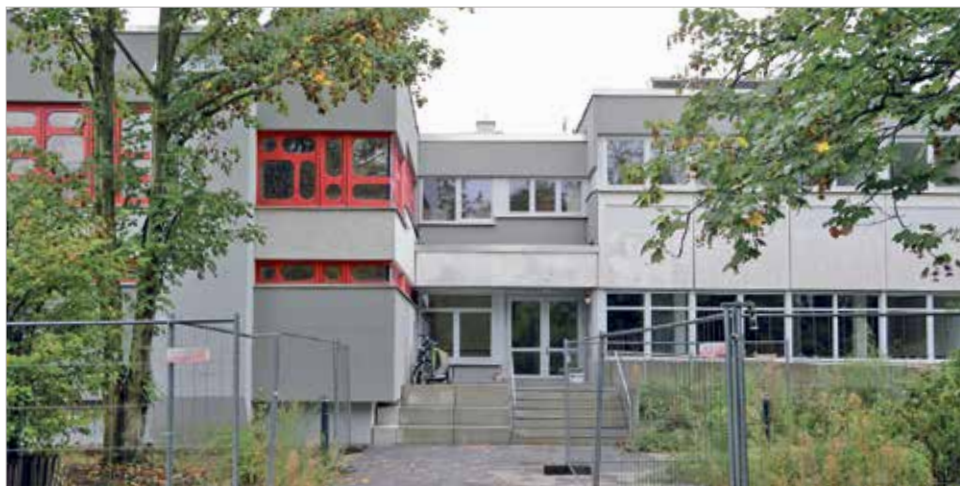
Das Haus umfasst zukünftig, auch für die Öffentlichkeit zugänglich, einen Saal, eine Turnhalle und einen Versammlungsraum
